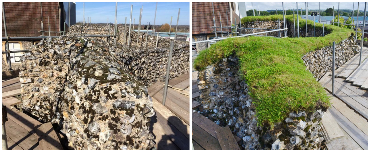
Figura 1 | Muratura del transetto sud delle rovine dell'abbazia di Reading (Berkshire, UK) prima e dopo l'intervento di “ soft capping ”. Fonte: https://www.readingmuseum.org.uk/blog/turf-cappings-reading-abbey .
