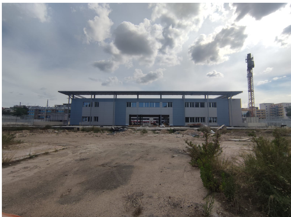
Figura 11 | Cantiere nuovi uffici.
