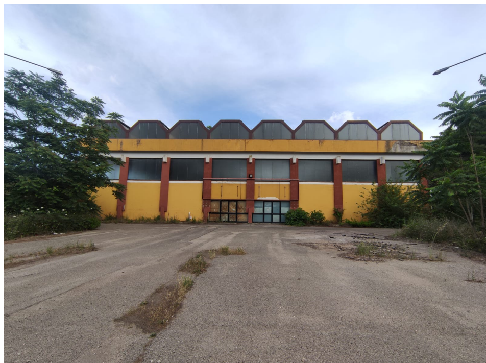
Figura 9 | Padiglione edificato durante gli anni '70.
