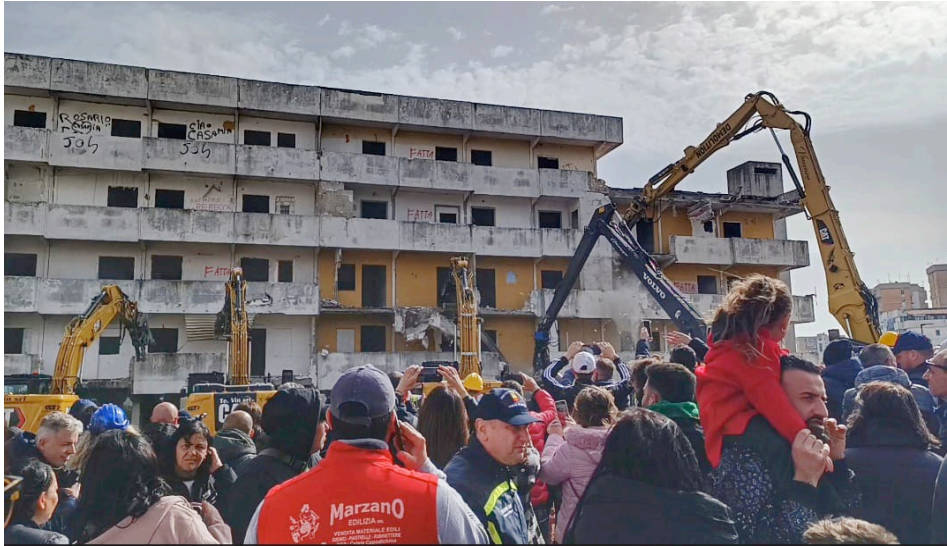
Figura 2 | La demolizione della Vela Gialla. Foto di G. Arillotta
