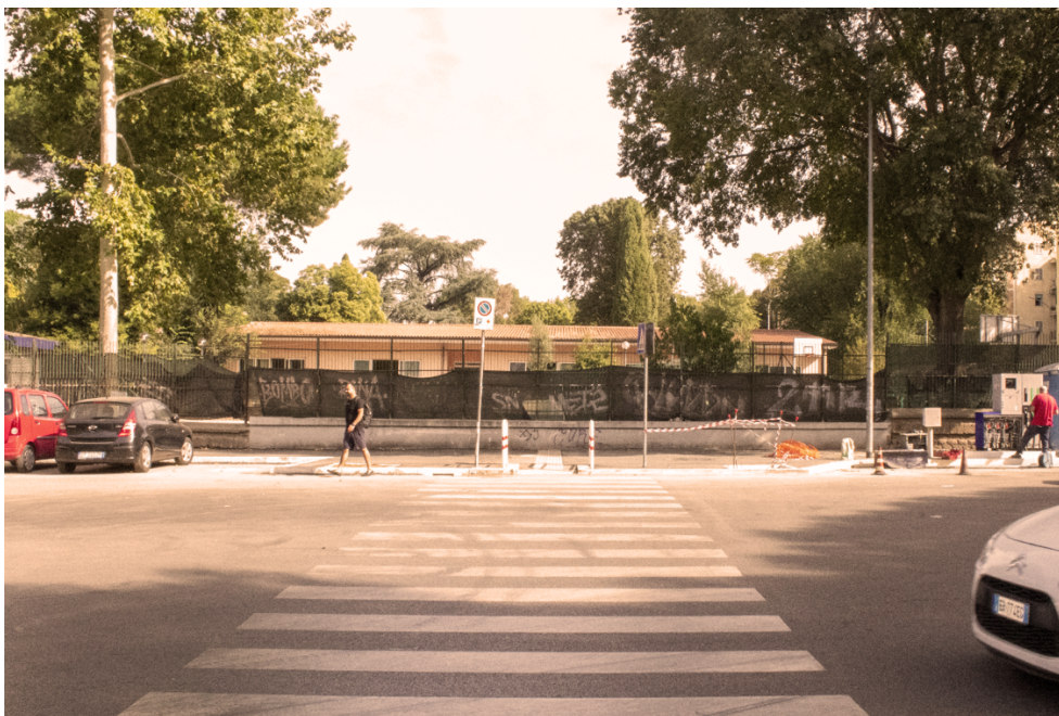
Figura 2 | Marciapiede asfaltato nel quartiere Ostiense. Largo Leonardo Da Vinci, Roma 19/09/2023 Fonte: Marco Ranzato
