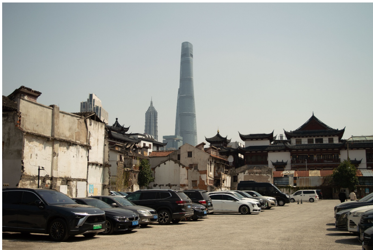
Figura 2 | Il quartiere della Old City oggetto di demolizioni e trasformazioni strutturali. Fonte: elaborazione dell'autrice
