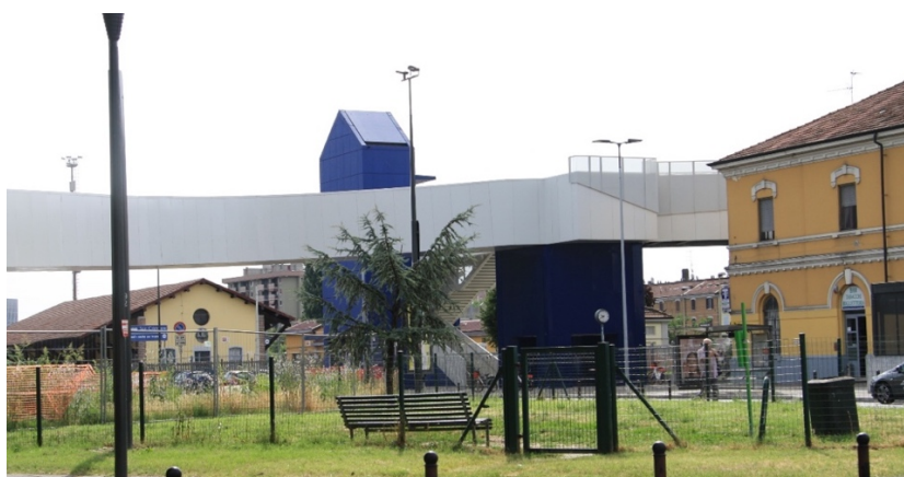
Figura 2 | Passerella di Scavalco al capolinea della M4 presso la stazione di San Cristoforo.
