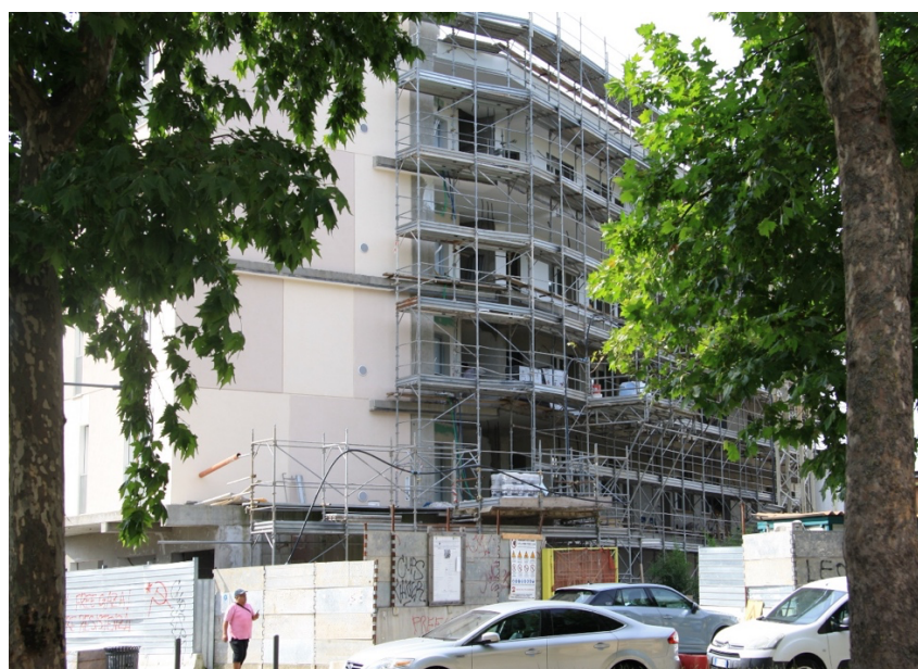
Figura 5 | Ricostruzione edificio Lorenteggio.
