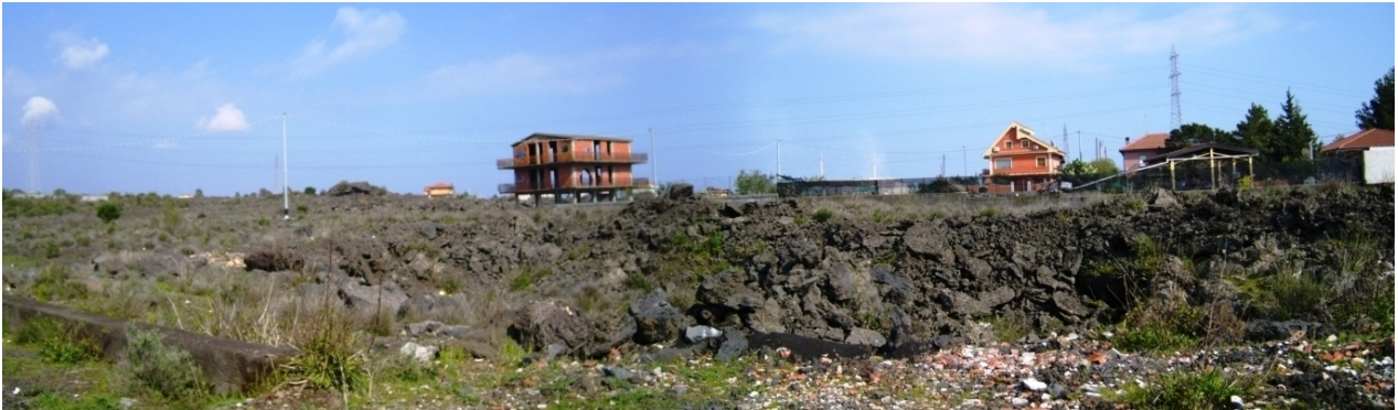
Figura 3- Villaggio dei Pini-Le Ginestre: il terreno sciaroso e la lottizzazione abusiva
