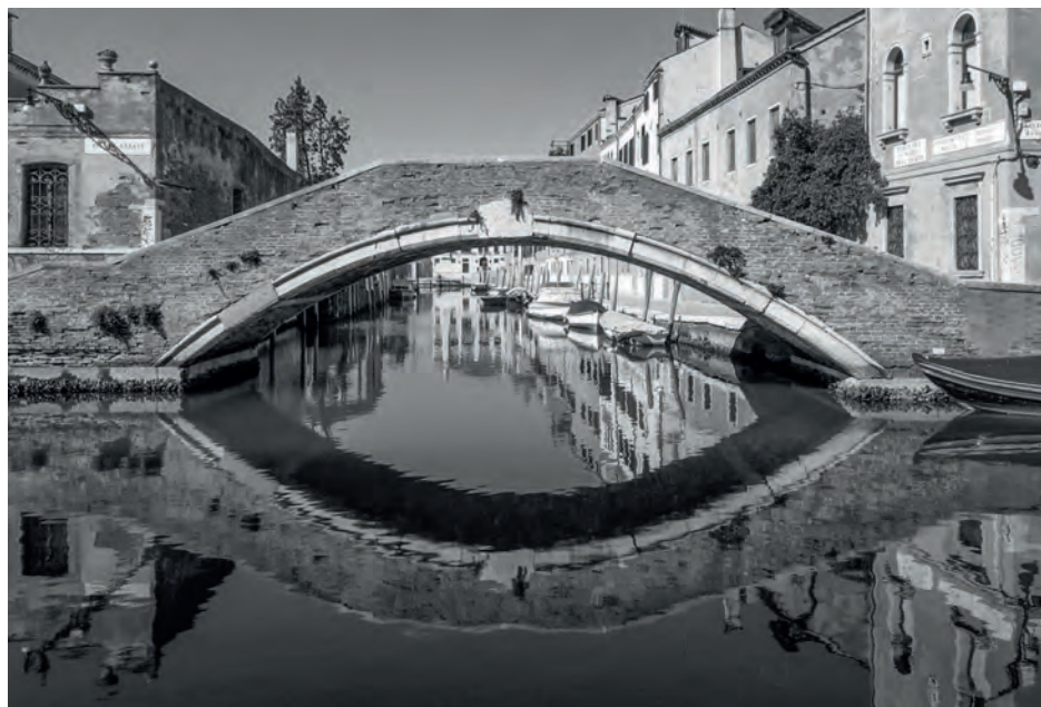
Venezia. Ponte sul Rio Briati, dal Rio dei Carmini.
