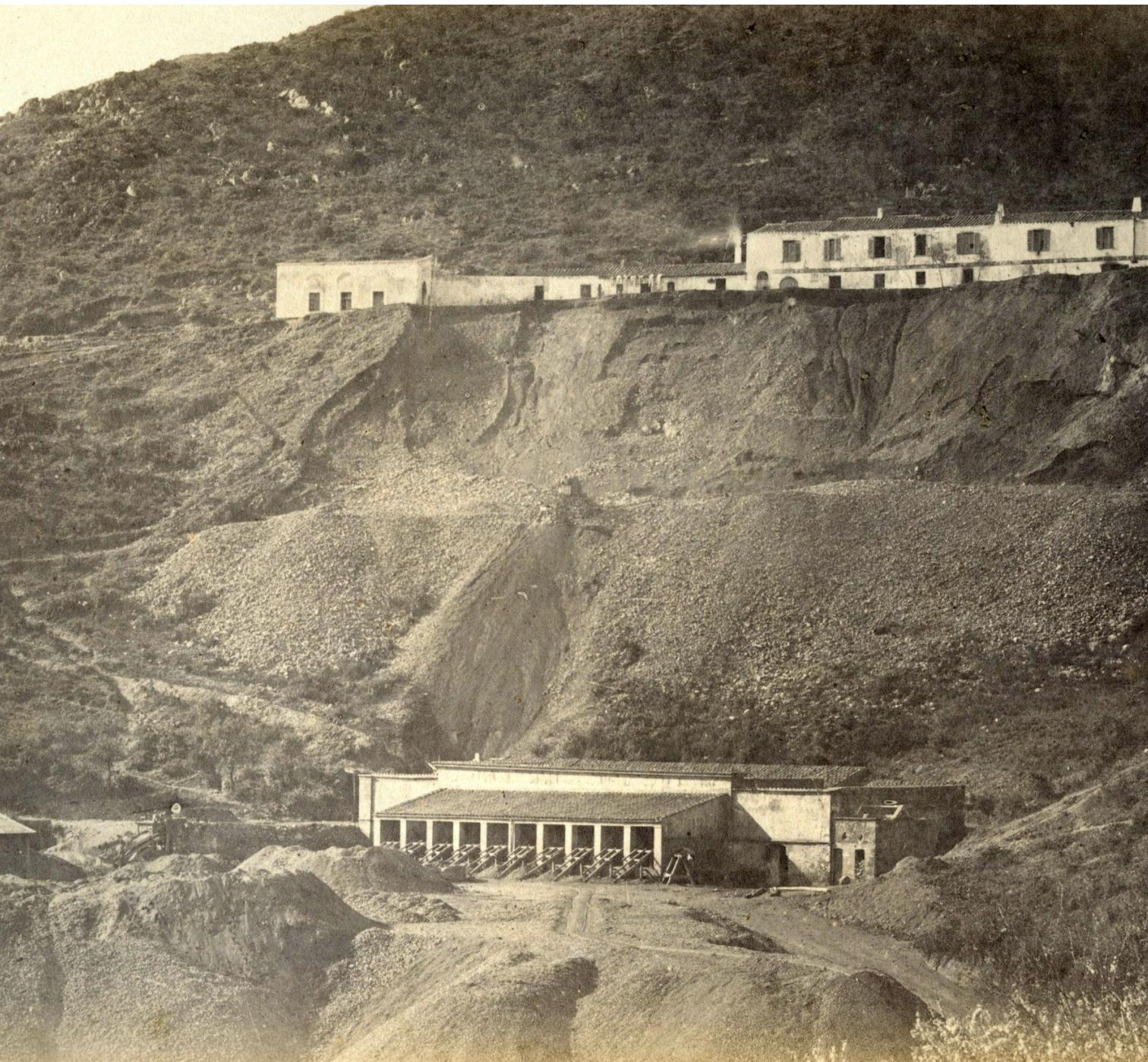
*Figura 4* | ASCI, F. MP-MV, SF, Busta 2.2c – f6. In basso la Laveria San Real costruita dal Keller sui ruderi di un preesistente magazzino, in alto il fabbricato a ridosso dell'imbocco della Galleria San Vittorio che al piano terra ospitava i magazzini e al piano superiore gli alloggi.
