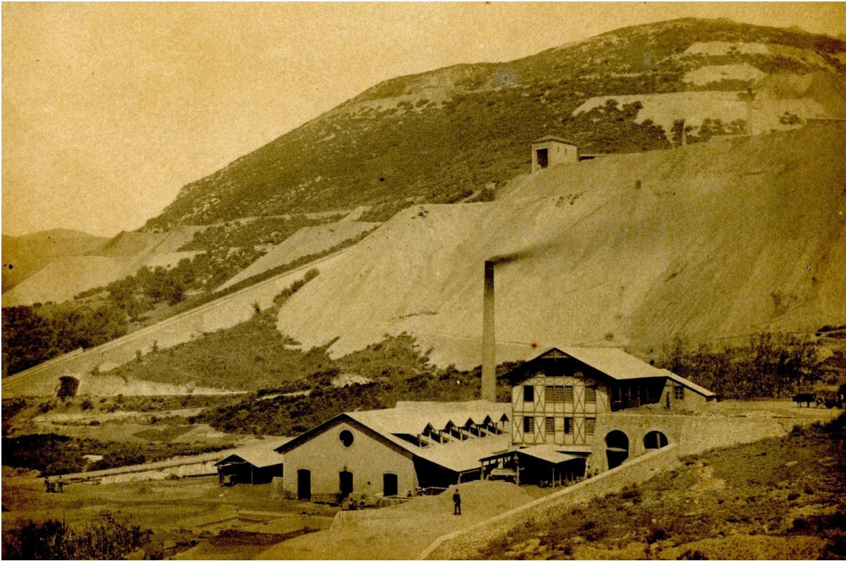
Figura 14 | ASCI, FMP-MV, SF, Busta 2 – 2c f4. La Laveria Pilla e la Laveria Sacchi in seguito unite per formare la Laveria Mamei. Sullo sfondo l'argano e il piano inclinato che collega gli impianti a monte con quelli a valle.
