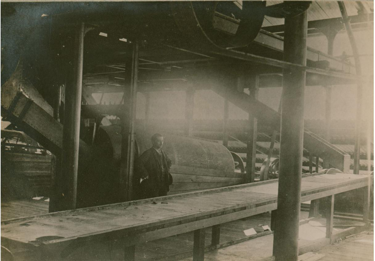
Figura 16 | ASCI, FMP-MV, SF, Busta 1-f 17. Erminio Ferraris nel livello più alto della Laveria Calamine, quello cioè dedicato alla vagliatura. Alle sue spalle un *trommel*.
