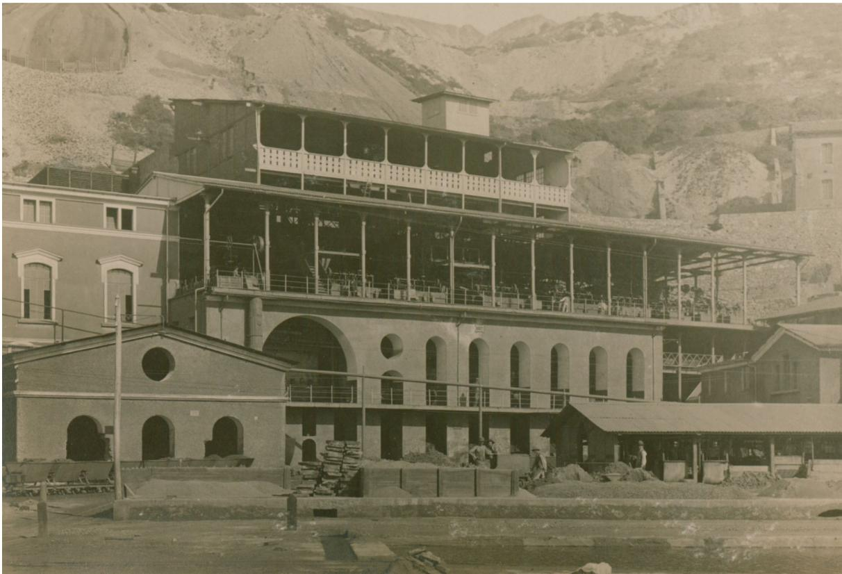
Figura 11 | ASCI, FMP-MV, SF, Busta 1 – f48. La Laveria Calamine progettata da Erminio Ferraris. Come il Pozzo e la Laveria Vittorio Emanuele, anche questo impianto è servito da un fabbricato dedicato alle caldaie.
