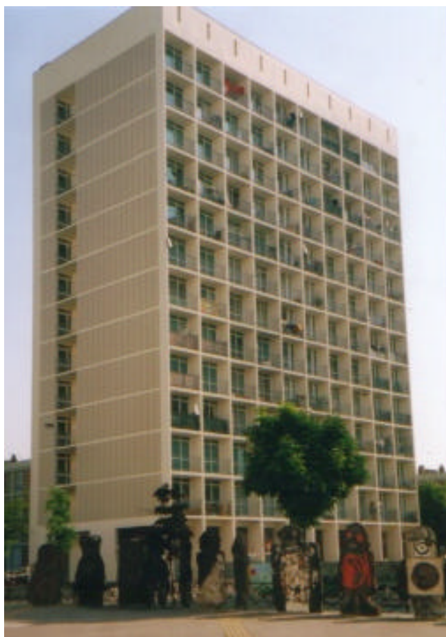
Les 4 Tours, Tour B réhabilitée et statuette en résines, place des enfants du monde (photo de l'auteur juin 2000)
